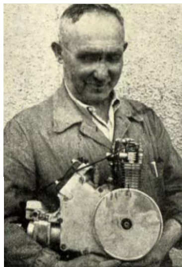
Abb. 4 Richard Jost, erster Mitarbeiter von Fritz Kleemann, mit Freises 63 ccm OHV-Fahrradmotor, dem Vorläufer des 250 ccm Motors der Ur-HOREX (HOREX Hauspost Nr. 1, 1951)
