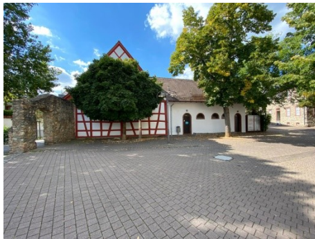
Ansicht Giebelfassade v. Kellereiplatz
