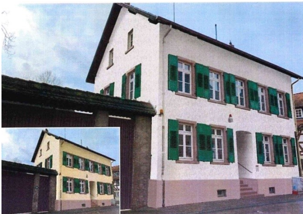
Mögliche denkmalschutzgerechte Fassadenerneuerung
