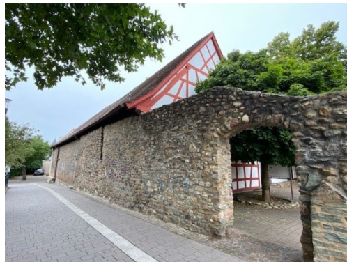
Ansicht vom Kellereiplatz
