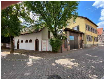
Ansicht vom Kellereiplatz
