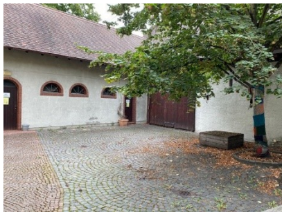
Ansicht vom Innenhof
