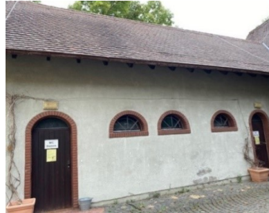
Ansicht vom Innenhof
