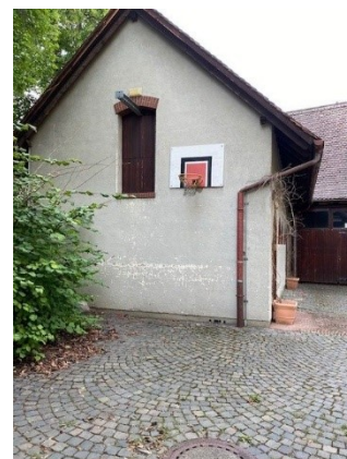
Ansicht Giebel vom Innenhof
