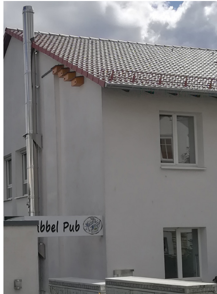
Treppenartig angebracht sind die Nistkästen für die in Kolonien brütenden Mauersegler. Foto: Stadt Königstein
