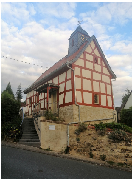
Frisch saniert: Das Ehrenbacher Türmchen. Foto: Stadt Idstein
