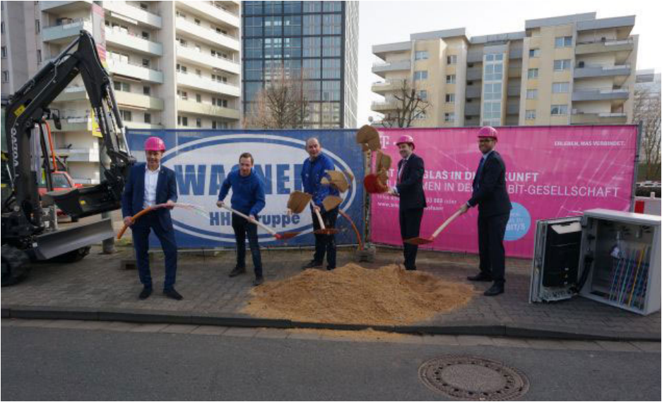
Am Glasfaserkabel: Bürgermeister Adnan Shaikh, an den Schaufeln: Moritz Schönherr und Tim Gräff sowie Fuat Dalar und Michael Löttner. Foto: Eckard Steffin
